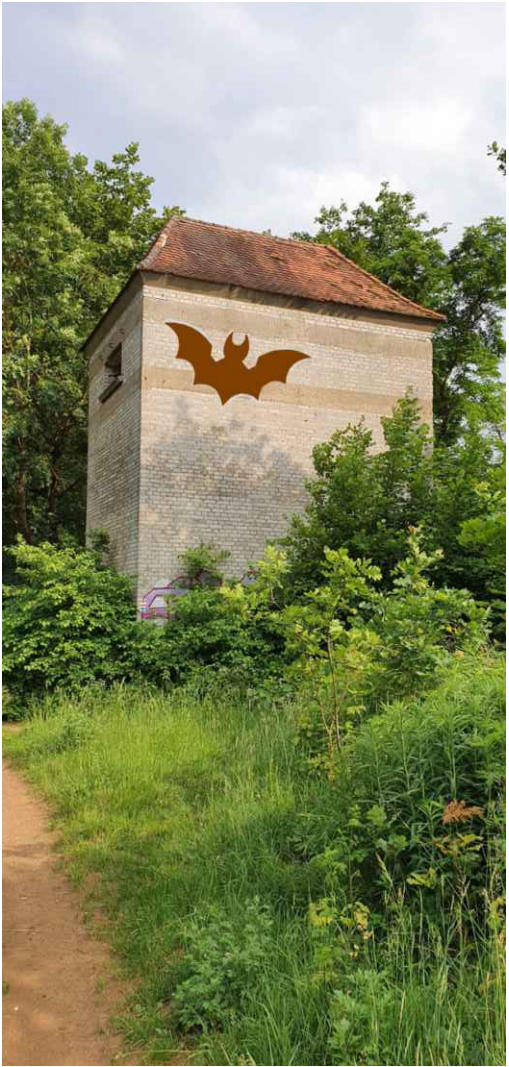
Trafoturm als Fledermausquartier umbauen
