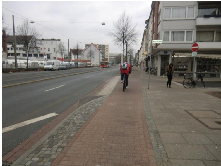
Abb. 4-11: Teilaufpflasterung im Einmündungsbereich einer Nebenstraße (Bremen).
