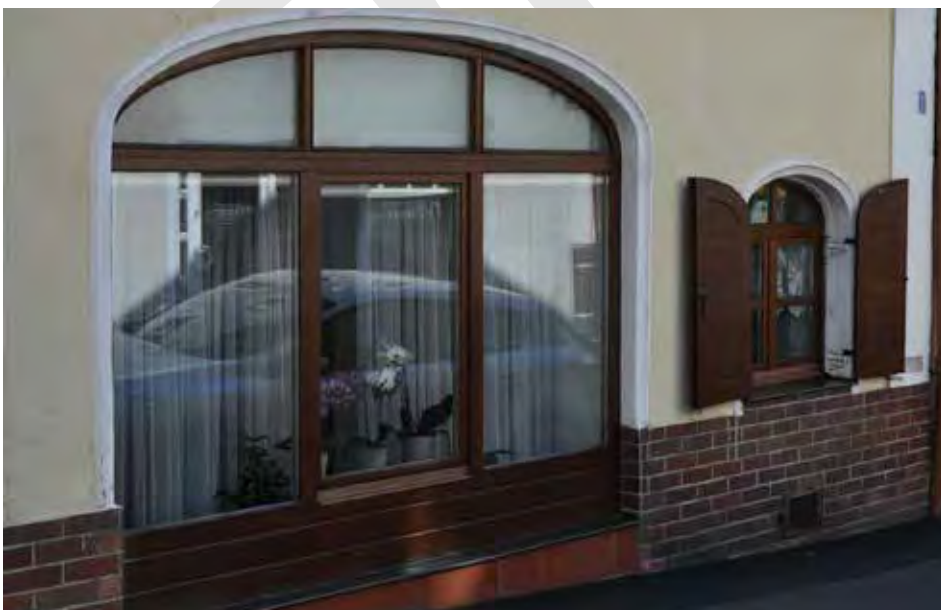
Abb. 59: Typische Leerstandssituation der 1c-Lage in Amberg (Aufnahme von ISR, 2017)
