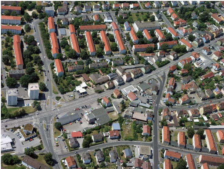
Abb.6: Schrägluftbild des Planbereiches AM 144 „An der Nordgaustraße“
